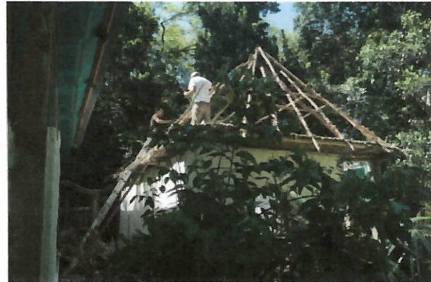
Proceso de rehabilitación de cocina y comedor, desmontaje de estructura del techo por estar en mal estado.
